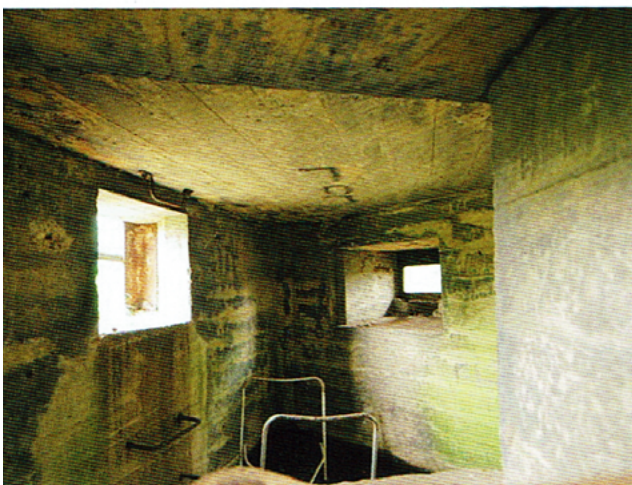
Linksboven: limietsteen Links: binnenkant kazemat S3 Rechts: kazemat S3 aan de Buursteeg
